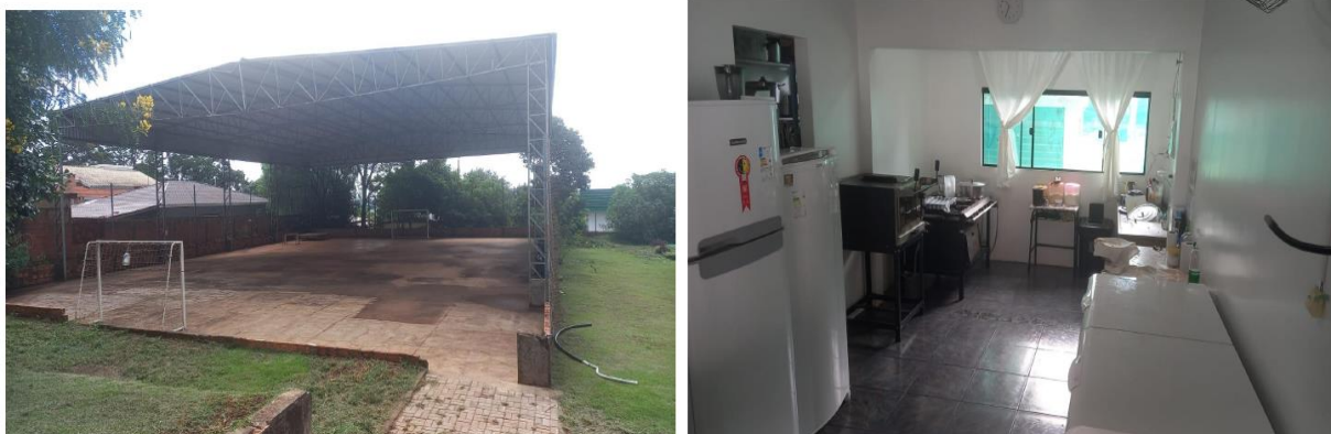
Figura 2.18. Infraestrutura da escola Tiradentes Link.
